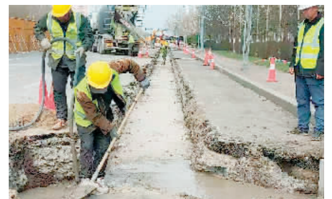
双城区雨污分流改造工程建设现场。
