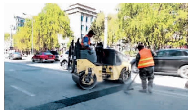
工人维修破损道路。
