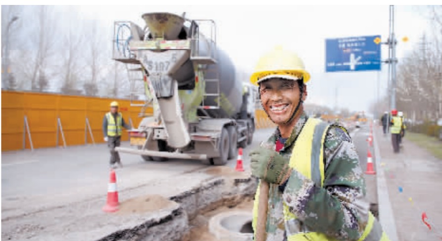
建设工人加班加点抢工期。
