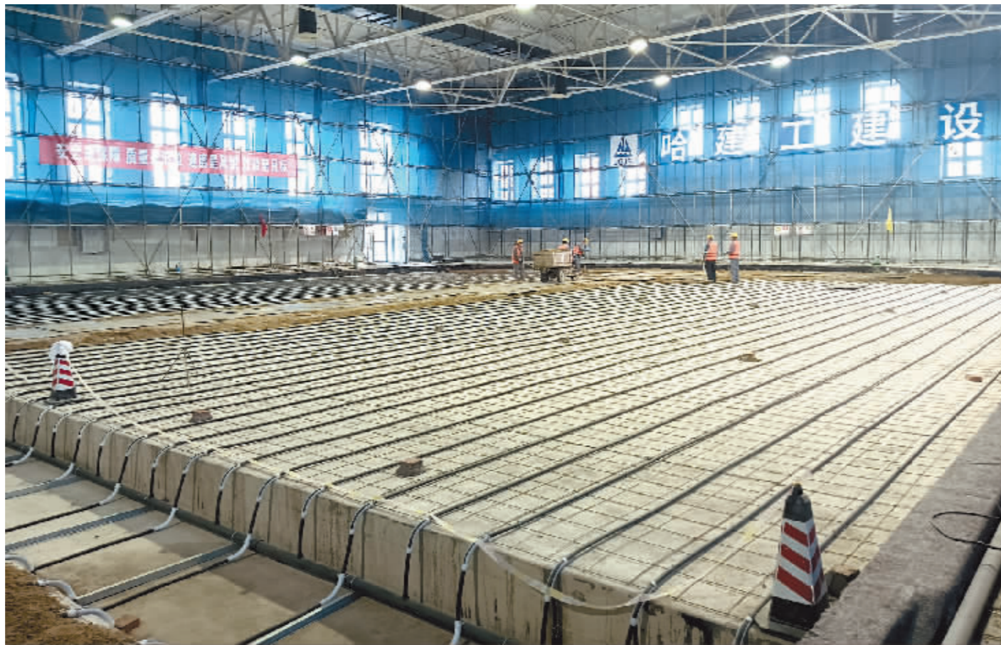
老训练馆已完成冰场PE管铺装,正在回填中砂。
