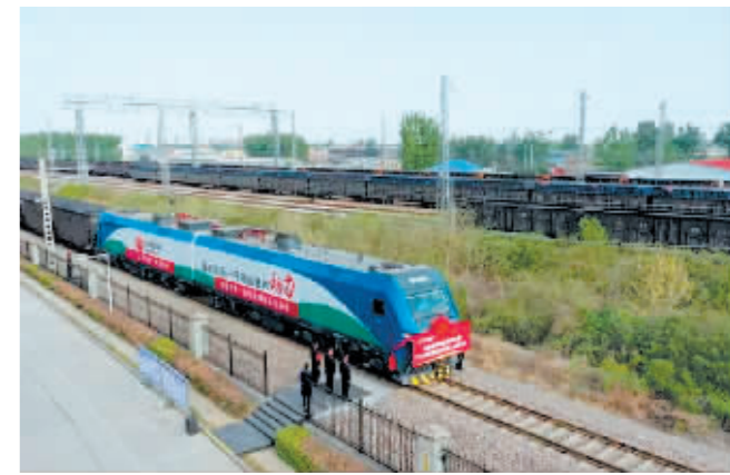
在朔黄铁路肃宁北站,准备开行的3万吨级重载列车。
