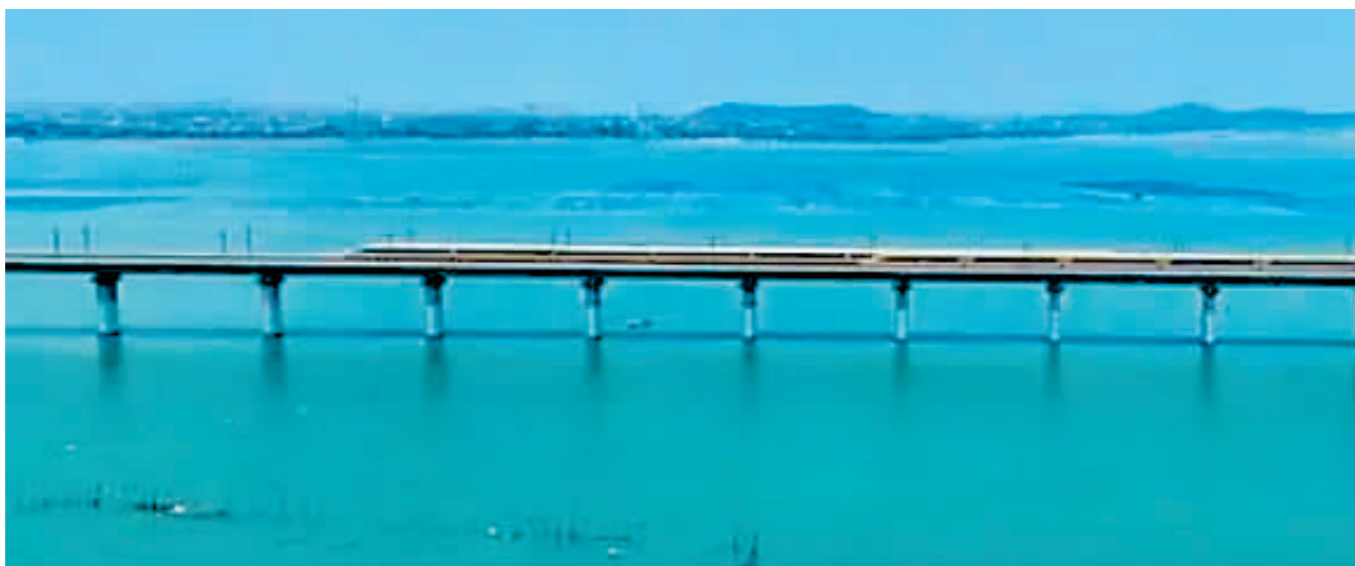
2023年6月28日，CR450动车组试验列车在涠洲湾跨海大桥交会运行，单列最高运行时速达到453公里。
