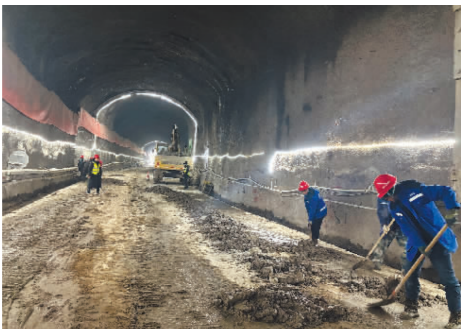
施工人员进行隧道路面清理工作。
