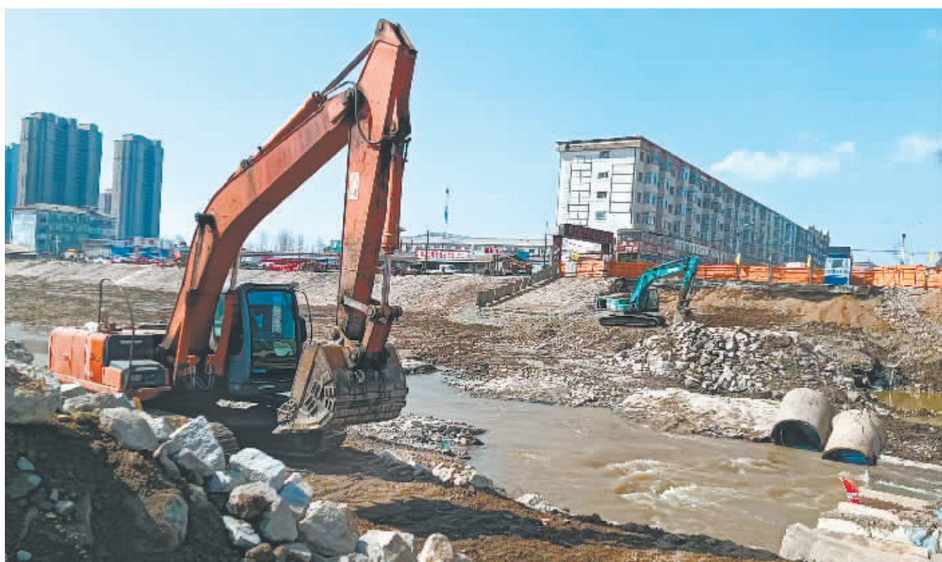
右图:珠河桥水毁灾后重建工程施工现场。
