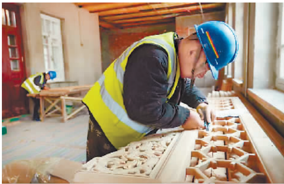
施工人员精细打磨装饰老建筑。
