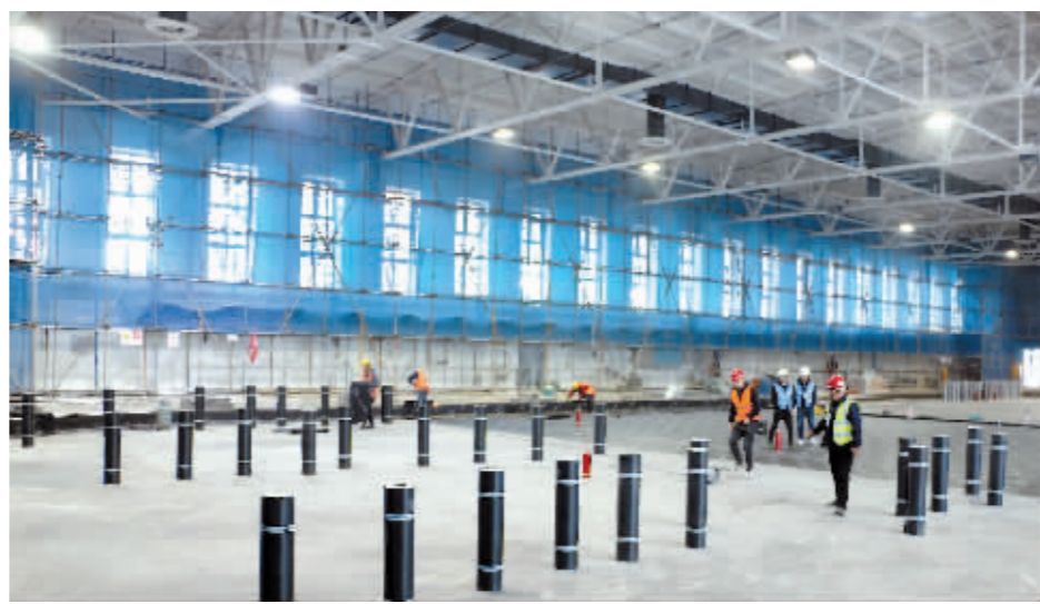
项目施工现场。
