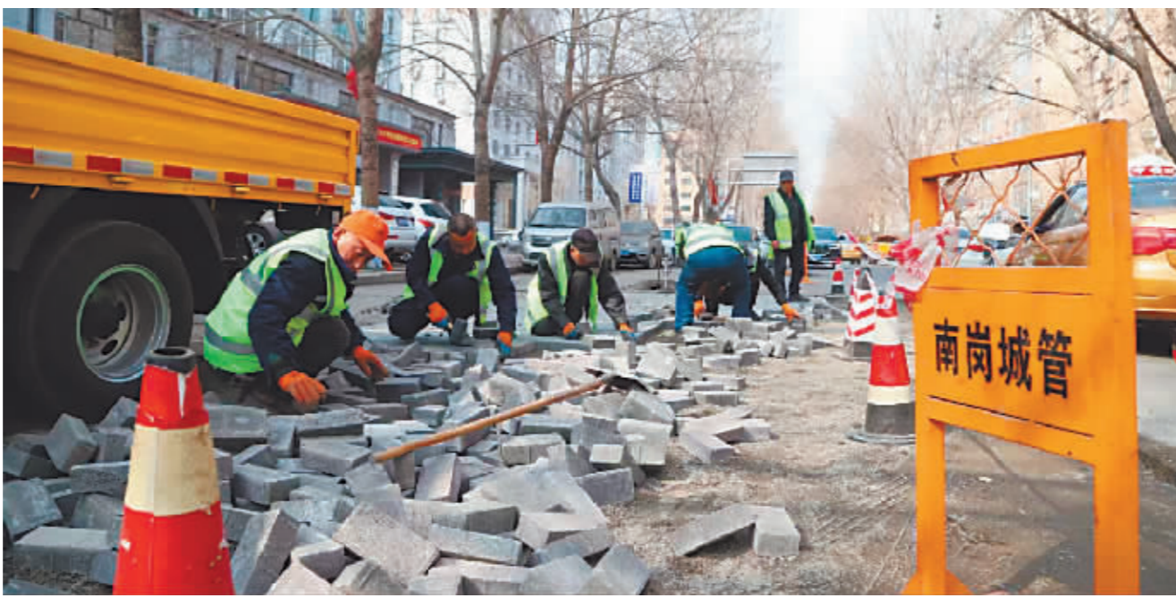
工作人员正在修补人行道、机动车道。
