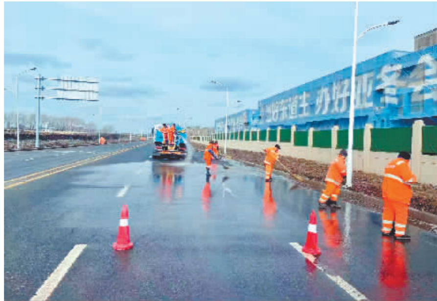
人机结合进行路面清洗作业。
