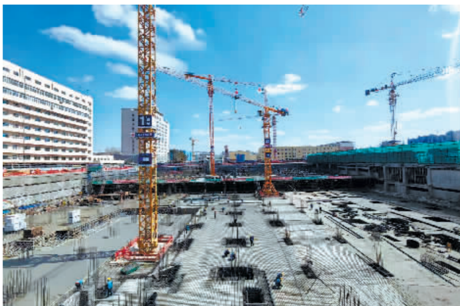
项目施工现场。
