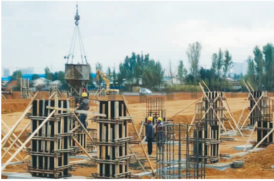
项目施工现场,工人们正在加紧作业。
