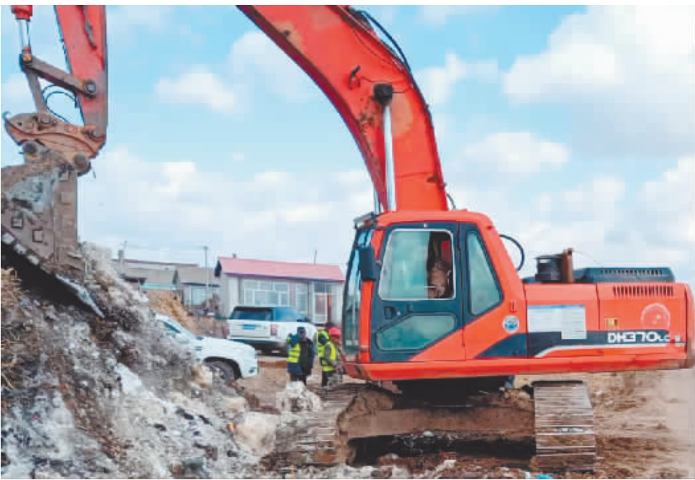
人机协同全力施工。
