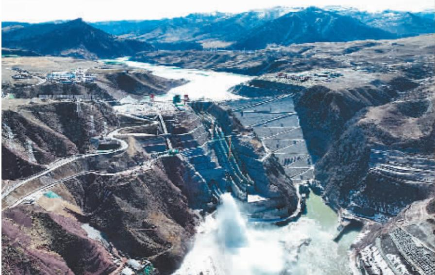
4月1日，玛尔挡水电站首台5号机组正式并网发电。该水电站位于青海省海南藏族自治州同德县与果洛州玛沁县交界处的黄河干流上，项目所在地平均海拔3300米，总装机容量232万千瓦，是黄河流域在建海拔最高、装机最大的水电工
