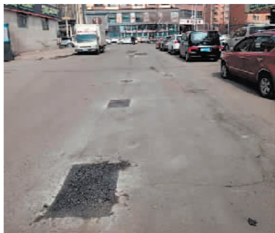
道路破损处已修复。
