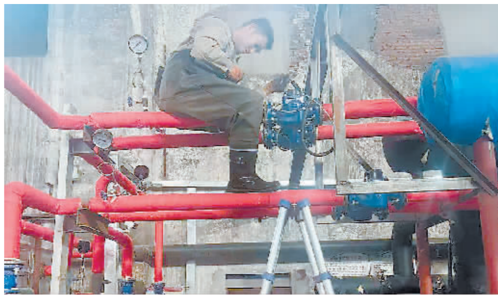
王鑫进行更换水表作业。
