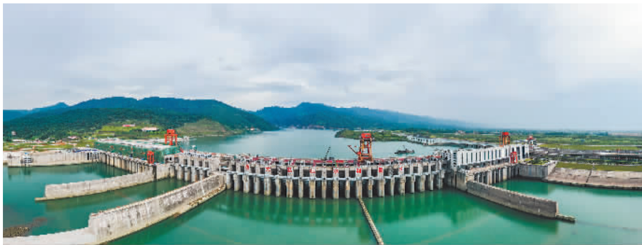
2023年9月2日拍摄的广西大藤峡水利枢纽。新华社发
