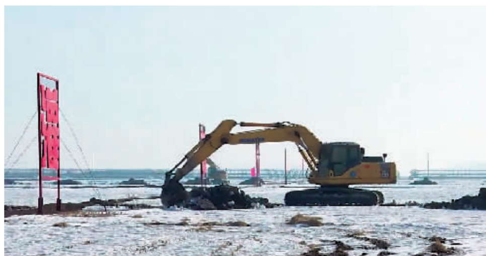
“大方田”改造现场。
