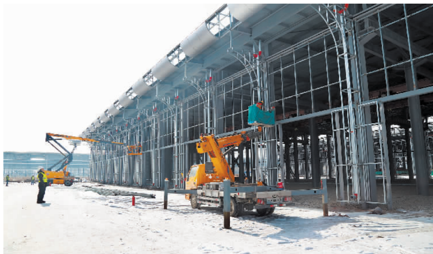
哈尔滨古铁市场钢铁产业园项目施工现场。
