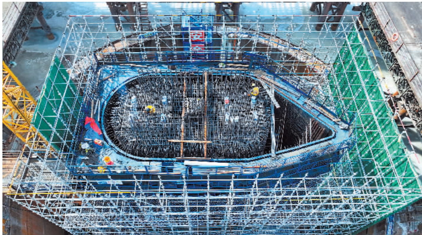
永兴呼兰河特大桥进行桥墩施工。
