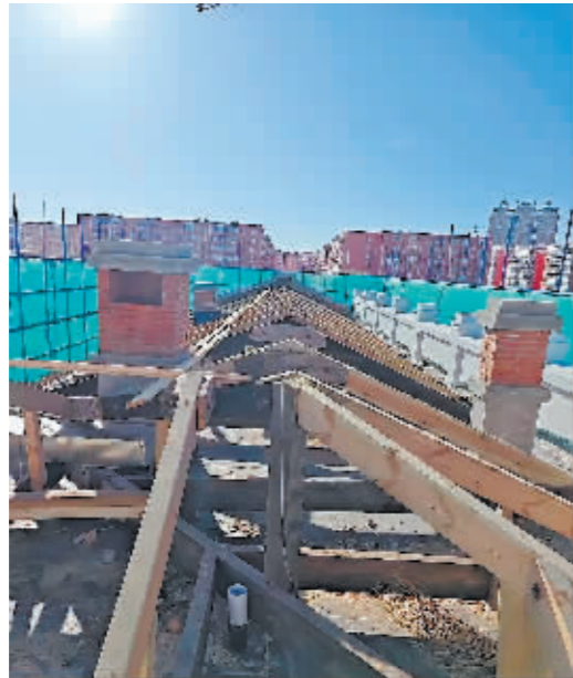
木屋屋顶修缮。
