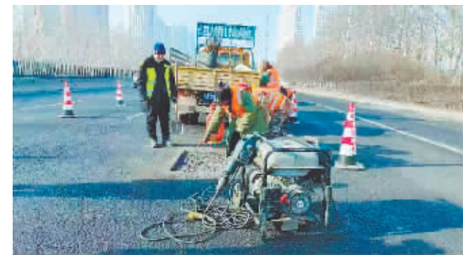
城市道路管护部门对道路进行维修。
