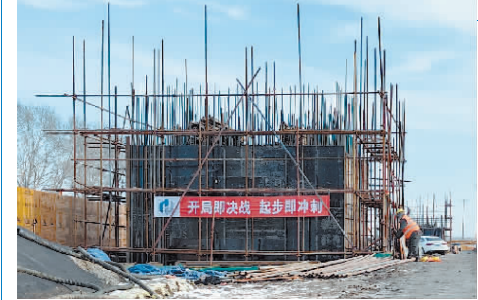
建工集团重点项目施工现场。
