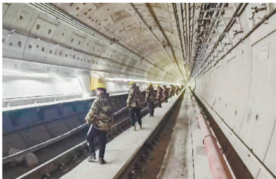
地铁3号线西北半环进入机电安装阶段。
