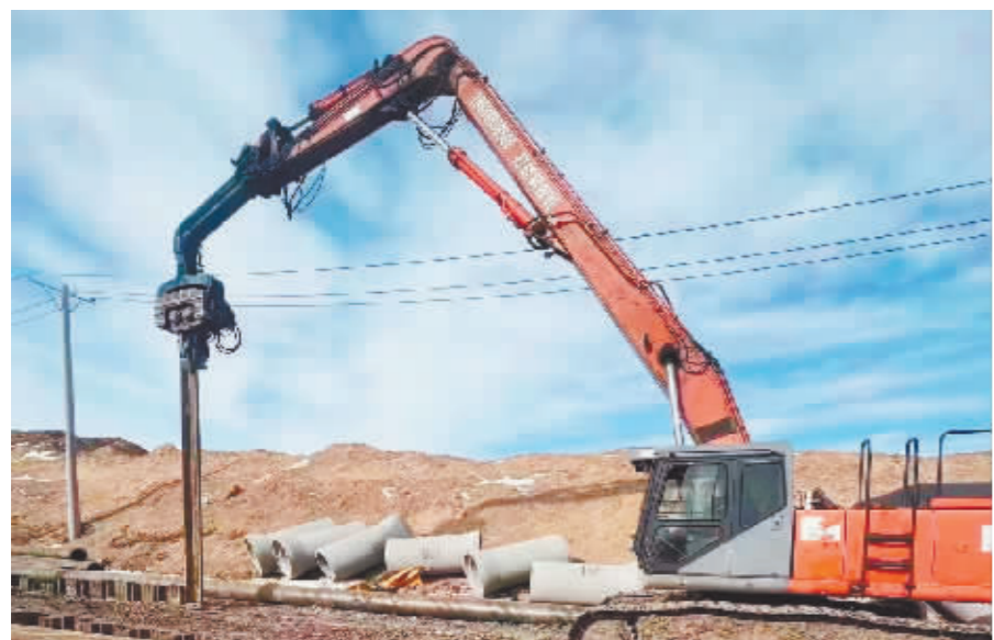
哈尔滨机场二期扩建工程施工现场。
