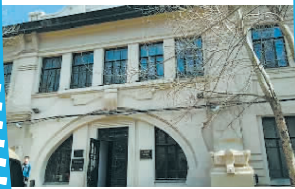
原俄国驻哈尔滨总领事馆旧址。
