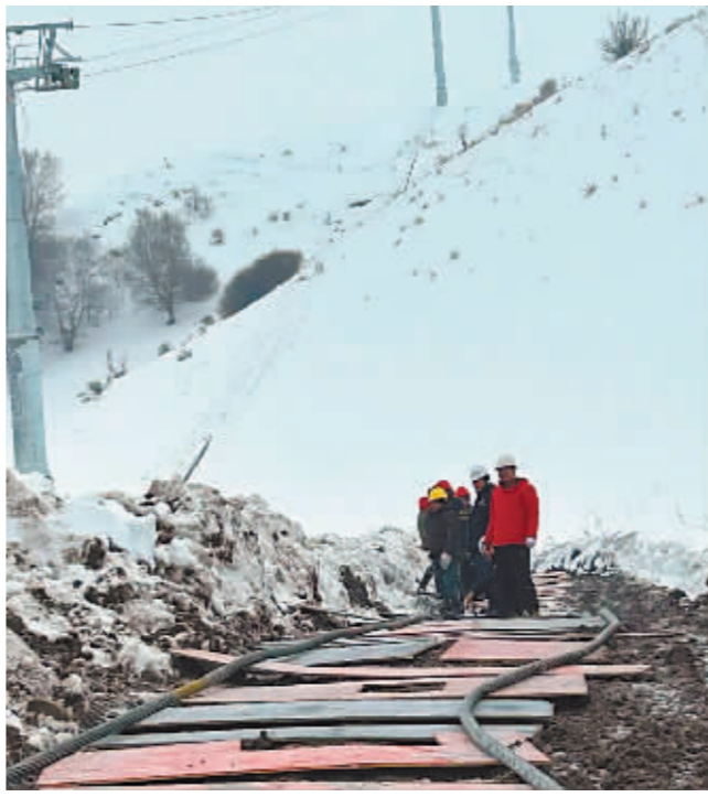
新疆华通泰克游乐设备有限公司工人在施放索道主钢丝绳，准备编接主缆。
