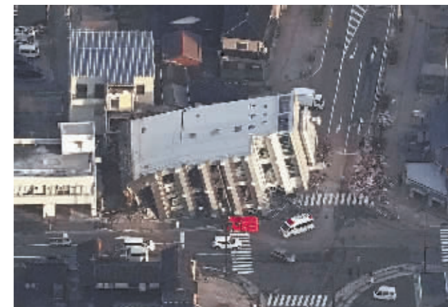
在日本石川县轮岛拍摄的倒塌建筑。
