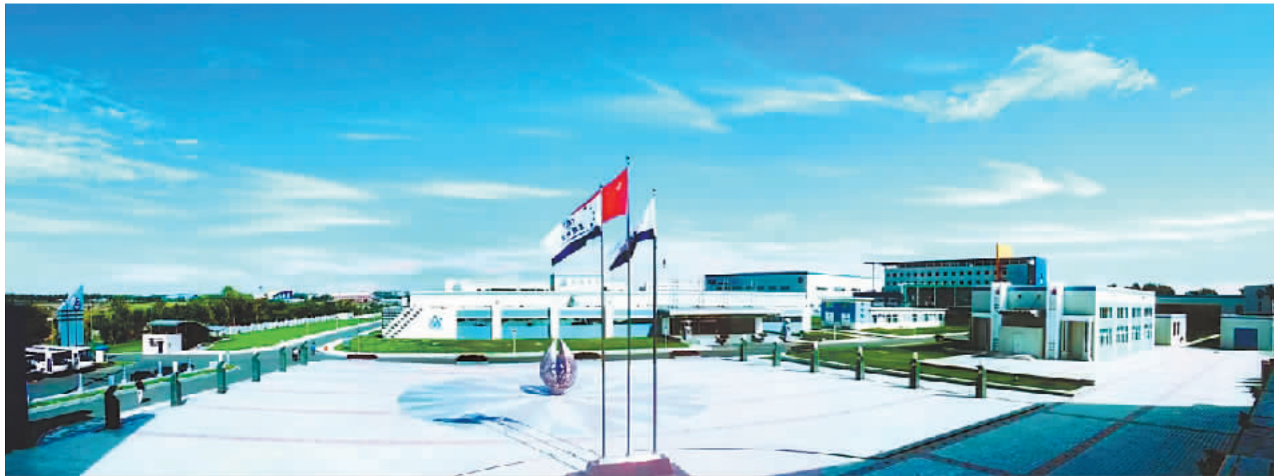
三精制药厂区。
