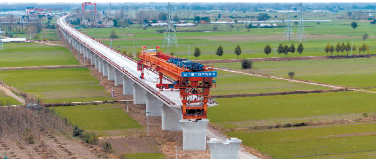
这是中铁四局在合肥市进行桥梁施工。新华社发
