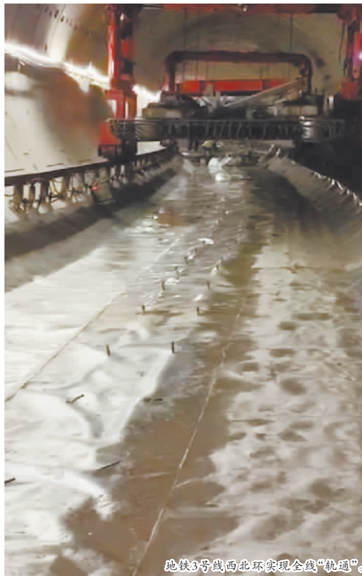
地铁3号线西北环实现全线“轨通”。
