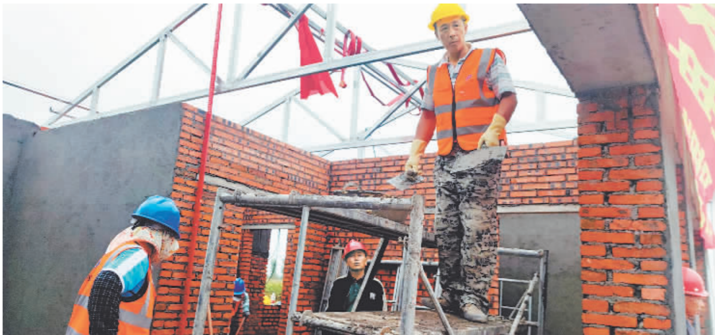
9月10日,施工人员在龙王庙村加班加点为受灾群众重建新房。(本报资料片)
