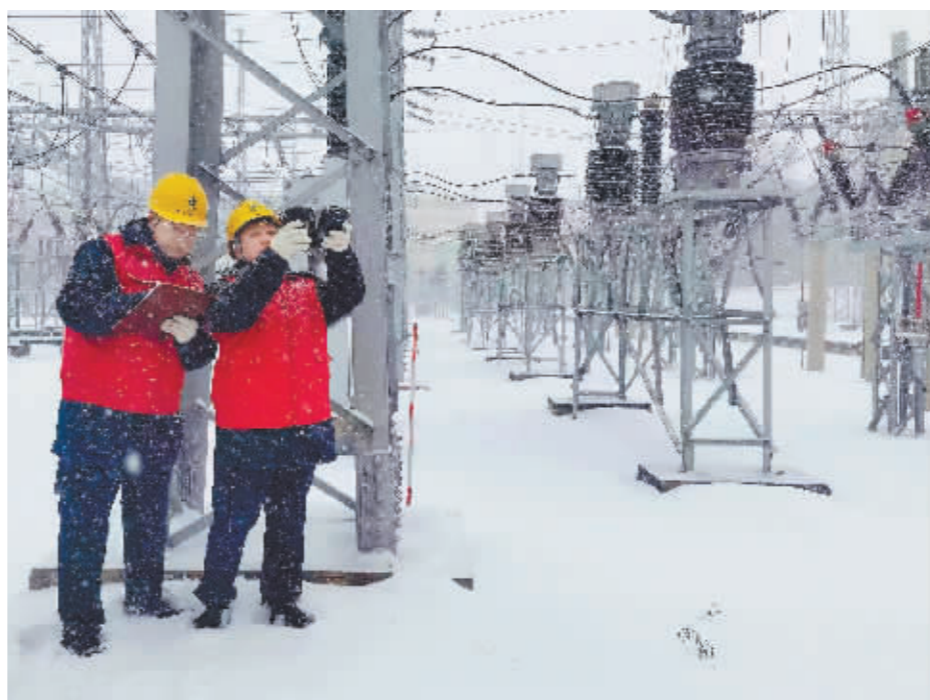
工作人员对电网设备进行巡检。
