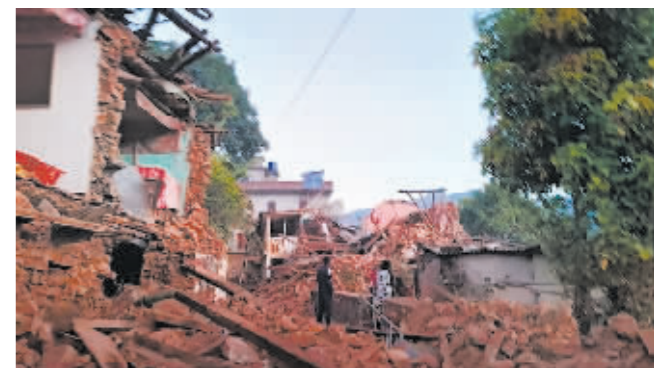
这是 11 月 4 日在尼泊尔西部扎泽尔果德拍摄的被地震损毁的房屋。 新华社发
