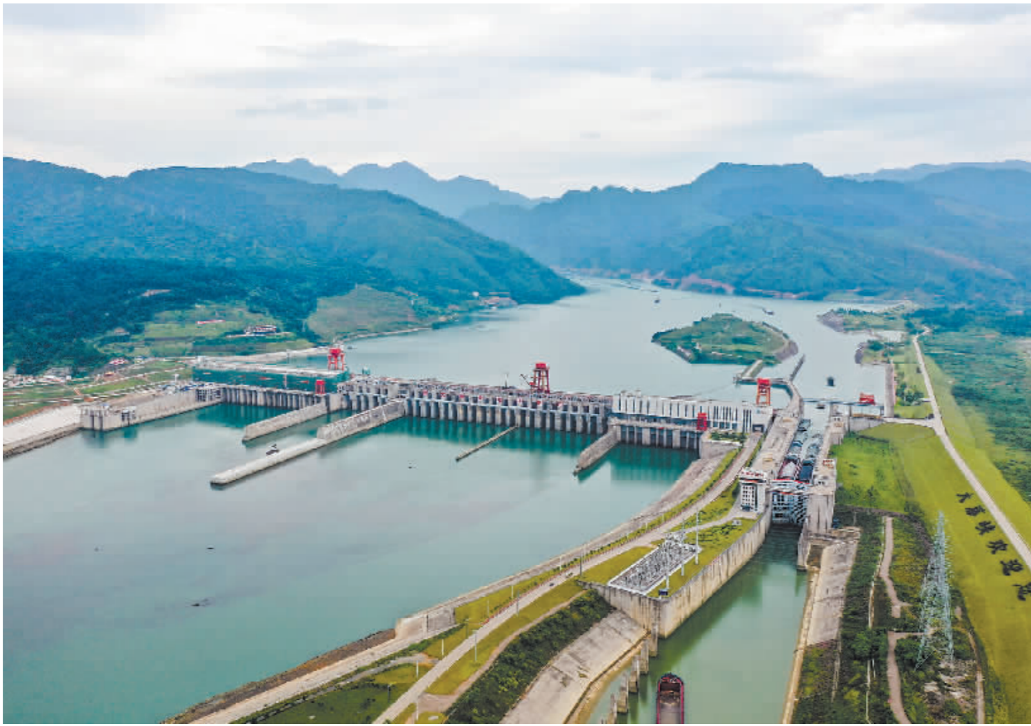
9月2日拍摄的广西大藤峡水利枢纽。 新华社发
