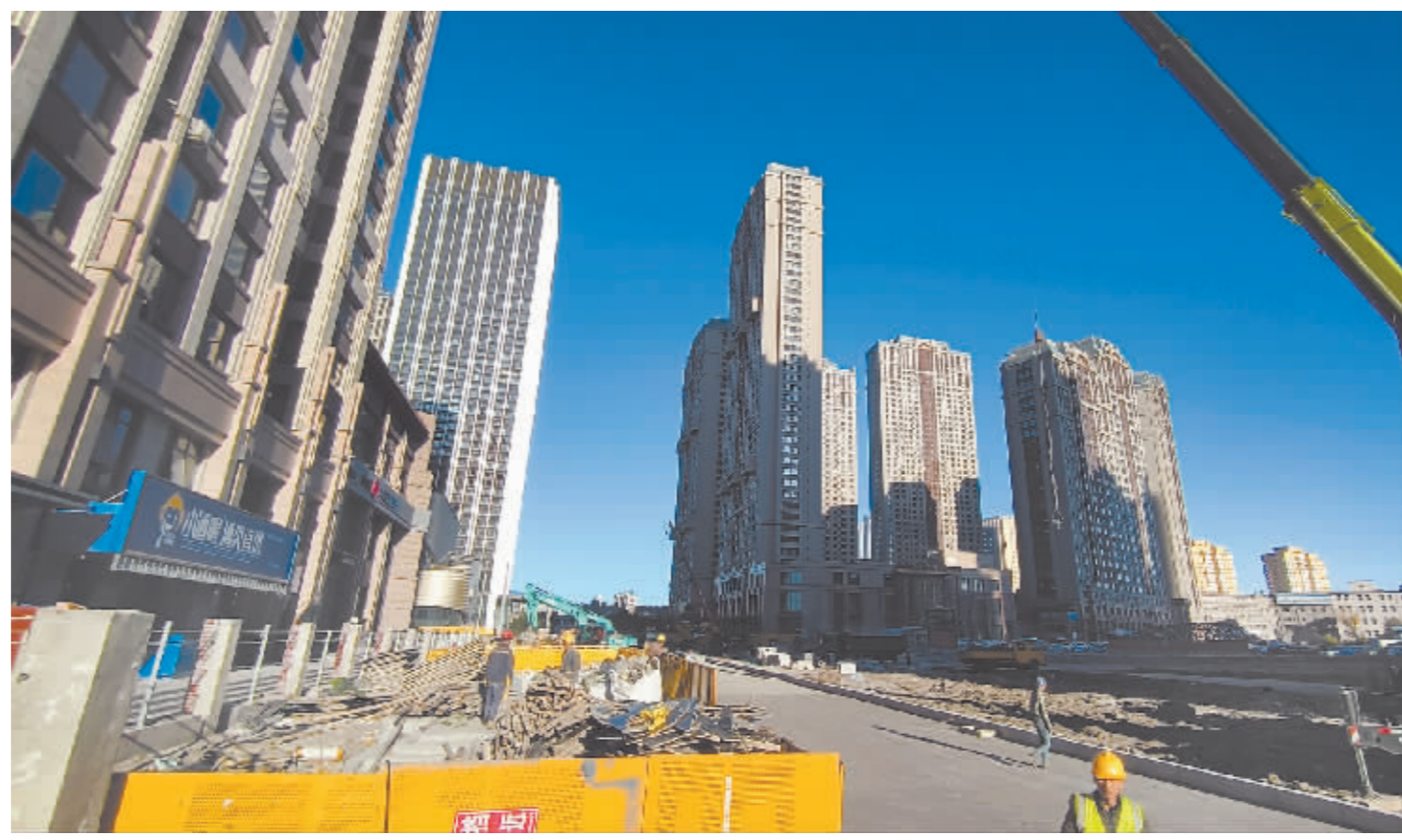
地铁三号线北马路施工现场。本报记者 温桥摄
