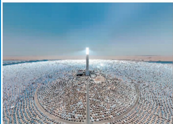
在阿联酋迪拜拍摄的上海电气迪拜光伏复合项目。位于阿联酋迪拜的700MW光热和250MW光伏复合项目由上海电气集团股份有限公司总包,装机规模大、技术标准高,助力阿联酋实现清洁能源目标。
