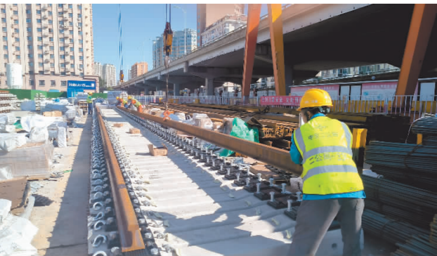
地铁建设者抢进度忙施工。
