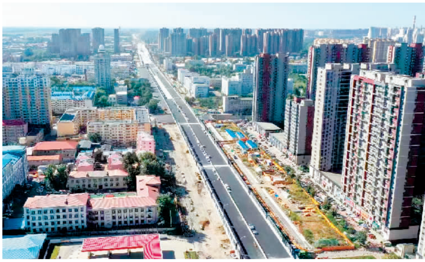
正在施工中的东三环快速路。
