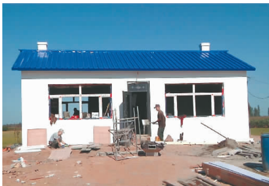
施工工人正在加紧建房。
