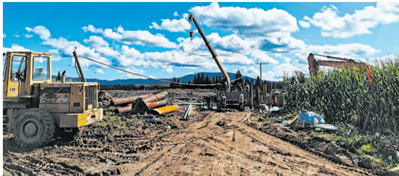
鱼池朝鲜族乡筒子沟村桥梁施工现场。
