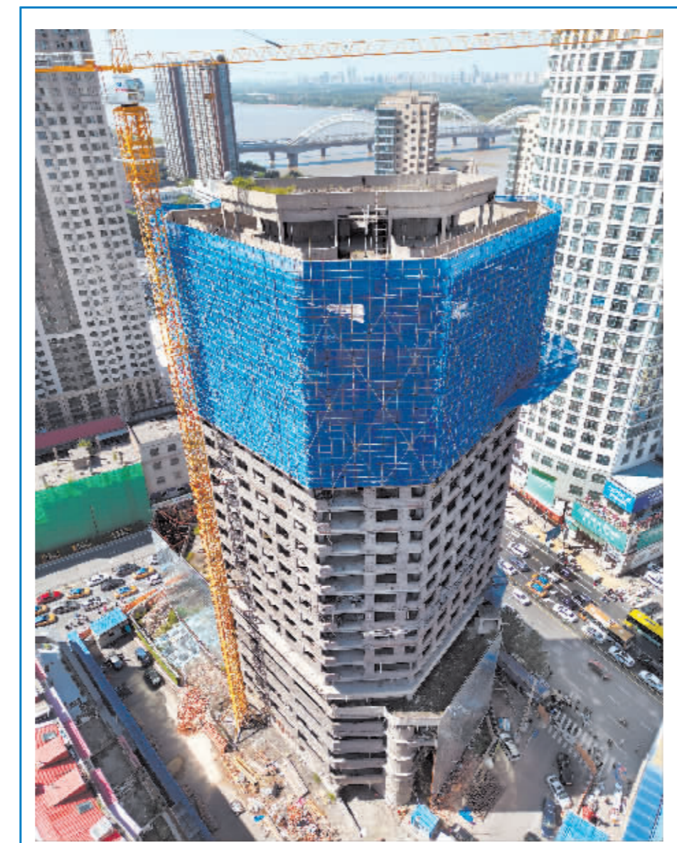
艺华大厦拆除工程准备就绪。本报记者 刘洋摄
