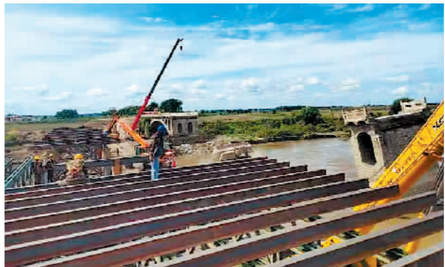
搭建便桥现场。
