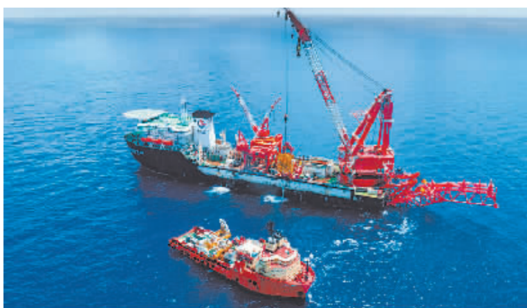
“深海一号”二期海底管道终端安装现场。
