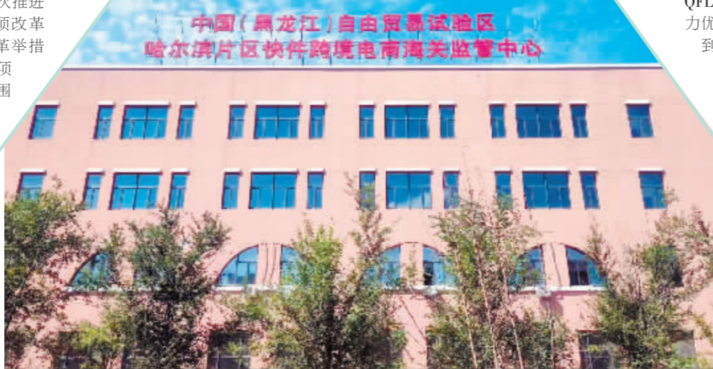
自贸区哈尔滨片区快件跨境电商海关监管中心。
