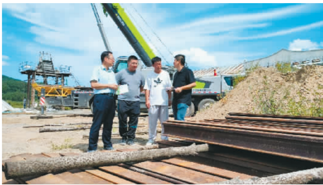
王凯(右二)等技术人员了解重建现场情况。
