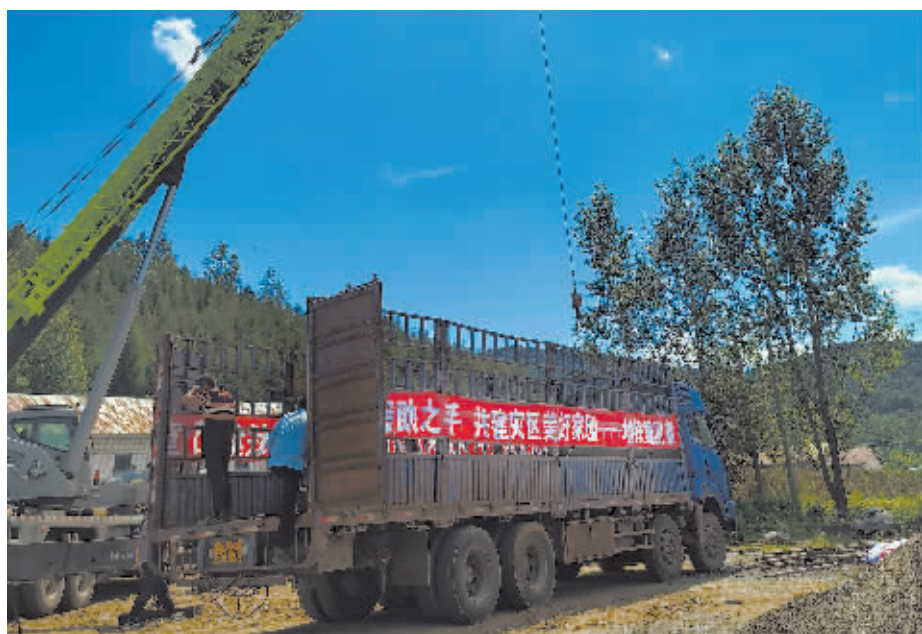
援建应急便桥施工现场。
