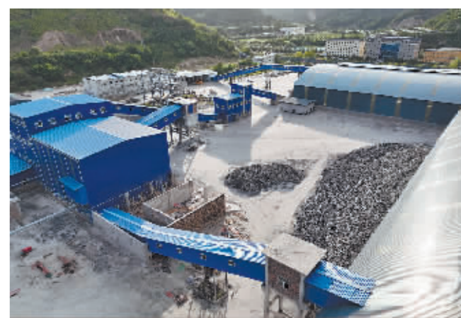
8月22日拍摄的新泰煤矿内爆事故现场。新华社发
