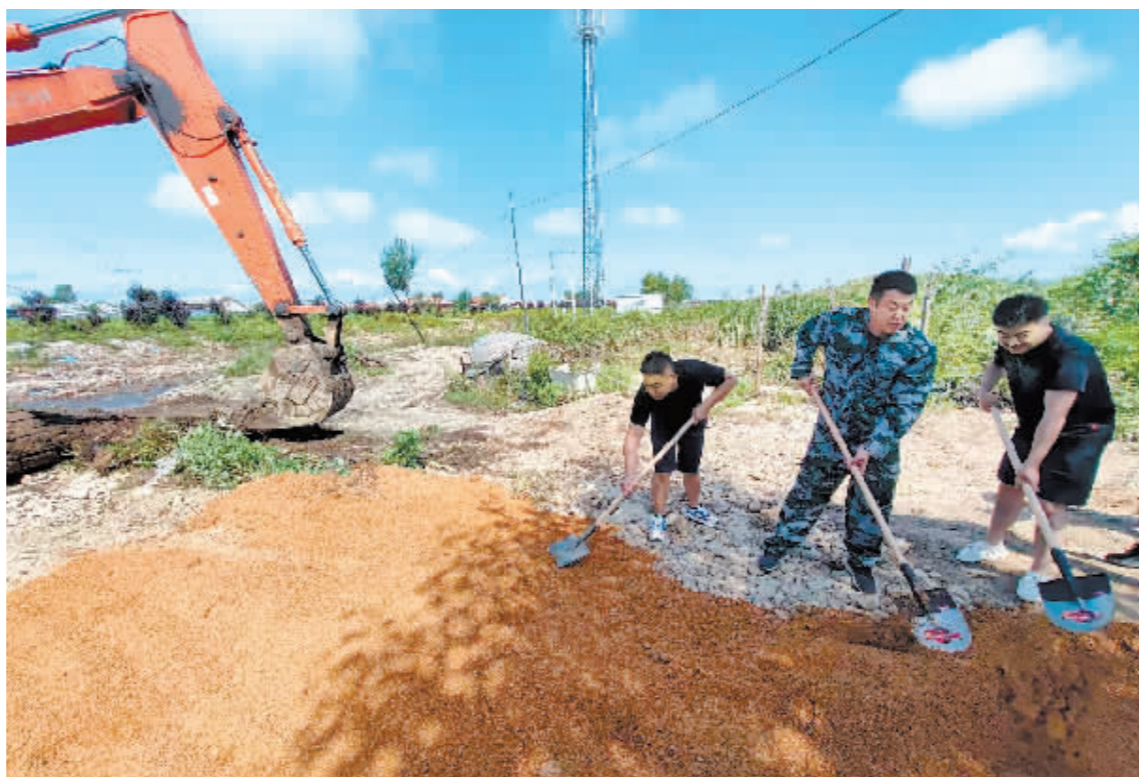
整修村屯受损道路。
