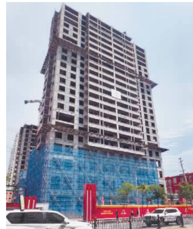
复建开工。本报记者 张大巍摄
