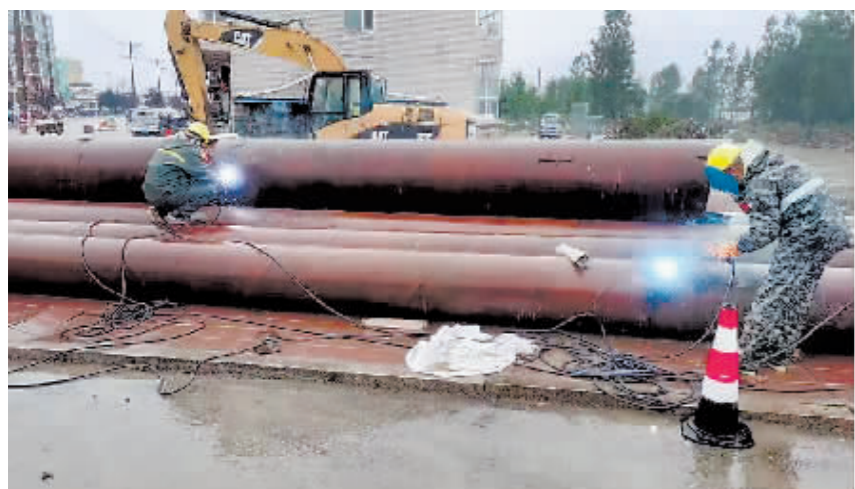
工人进行钢管焊接。
